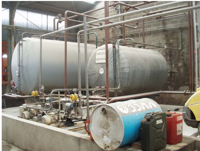
Photo3 : stockage de l'émulsion avant introduction dans le malaxeur
