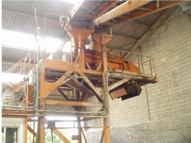
Photo 1 : malaxeur enrobés froids
