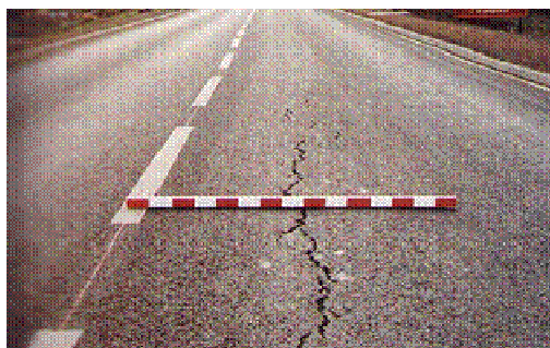
fissure longitudinale
