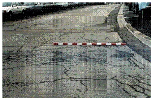
fissuration en « dalles »
