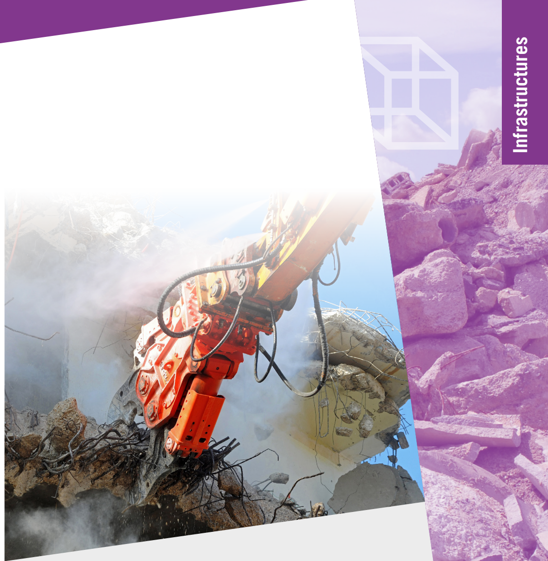
▲ Démolition à l'aide d'une tenaille
