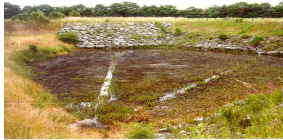
Figure 3 : Bassin d'infiltration des eaux pluviales de Ronchin (Lille)
