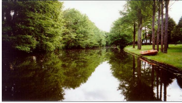
Figure 2 : Bassin de retenue des eaux pluviales de St Joseph de Porterie (Nantes)
