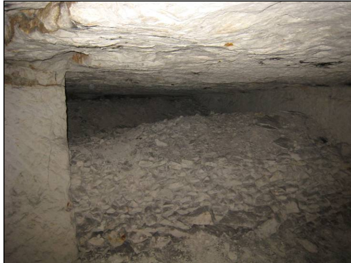
Figure 11 : les chutes de matériau lors de l'extraction de la pierre de taille en carrière souterraine sont stockées dans la cavité (LR Angers).
