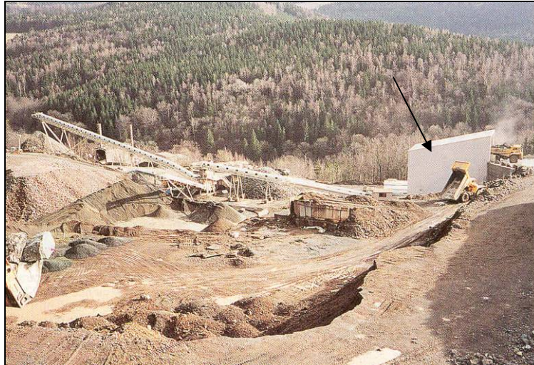
Figure 16 : exemple de dispositif de protection contre la poussière dans une installation de concassage criblage – à droite du capotage blanc, l'alimentation de la trémie par un camion (Photo de Mines&Carrières n°77)
