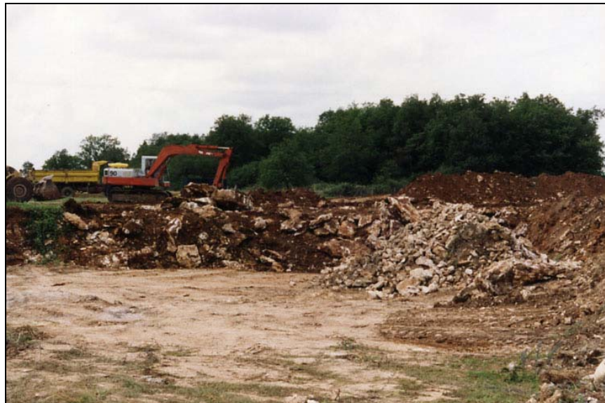
Figure 5 : réalisation de la découverte d'une carrière d'exploitation de calcaire (LR Nancy). Le matériau extrait est composé de calcaire et de limons argileux.
