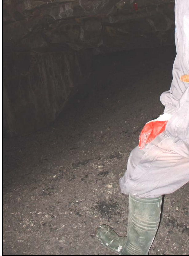
Figure 18 : cône de comblement d'une cavité avec du gravillon enrichi en ciment.
