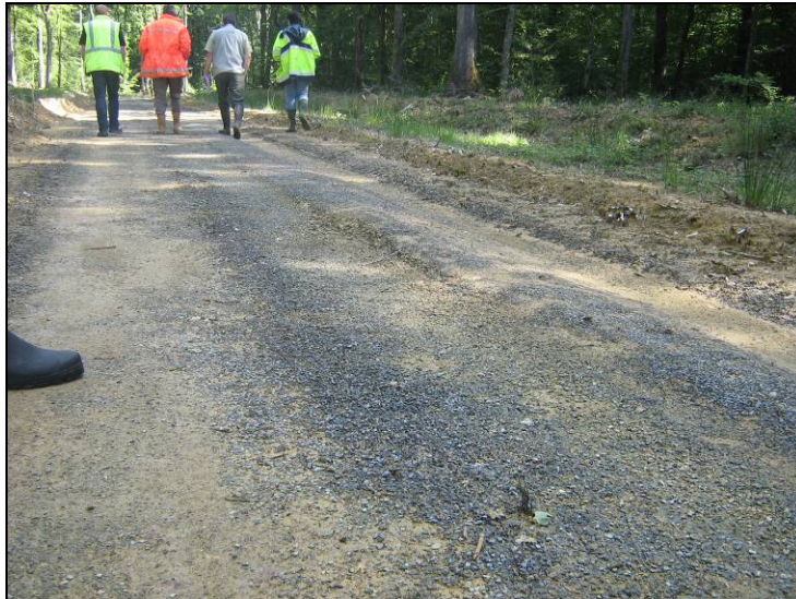
Figure 17 : chemin forestier en produit de scalpage traité à la chaux, ici recouvert d'un enduit de cure
