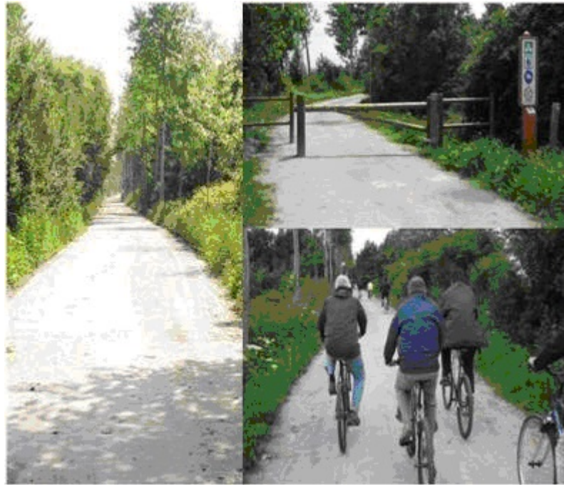
Figure 7 : Utilisation de la tange du Mont Saint Michel (Manche - 50), 70 000 m 3 (source : SEDIGATE)
