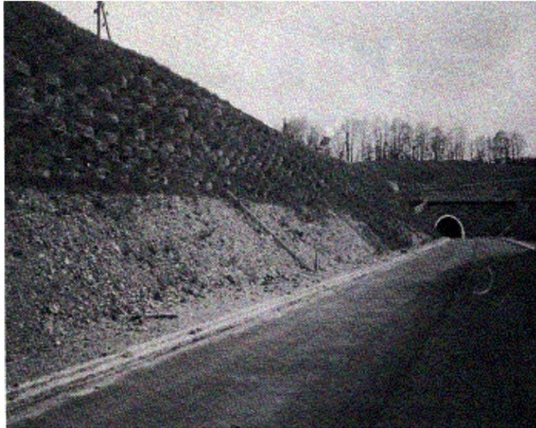
**Figure 7** - Vue d'un mur anti-bruit PNEUSOL<sup>®</sup> [Long, 1985]
