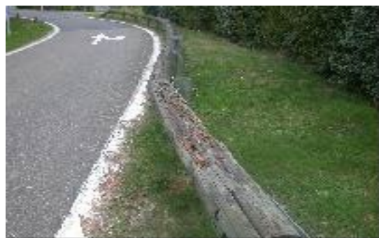
Figure 1 : dispositifs de retenue (photo : CETE Normandie Centre – 2001).
